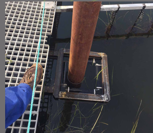
Dyrkningsflåder og pæle. På billedet til venstre ses rullebeslag som flåderne er fastgjort til pælene med.
