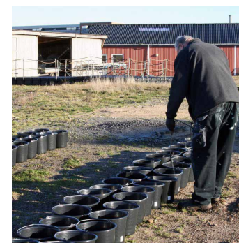
Støbning af betonblokke
