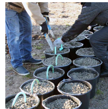
Håndtag støbes i betonen
