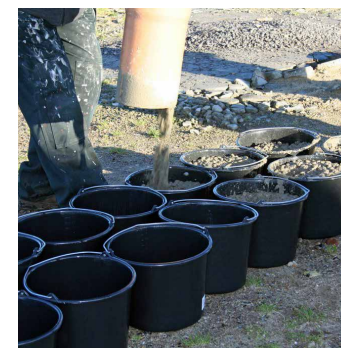
Støbning af betonblokke
