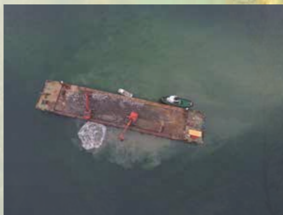
Stenene til stenrevet bliver fragtet ud til en stor pram, hvorfra to gravemaskiner placerer stenene på bunden af fjorden.
